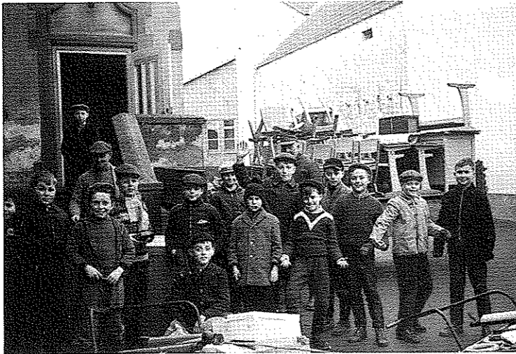
Bürgermeister Johann Baptist Eckert, Feldschütz Johann Georg Knußmann und die Buben des 4. und z.T. 3. Schuljahres räumen den alten Schulsaal unter der Bürgermeisterei aus.
